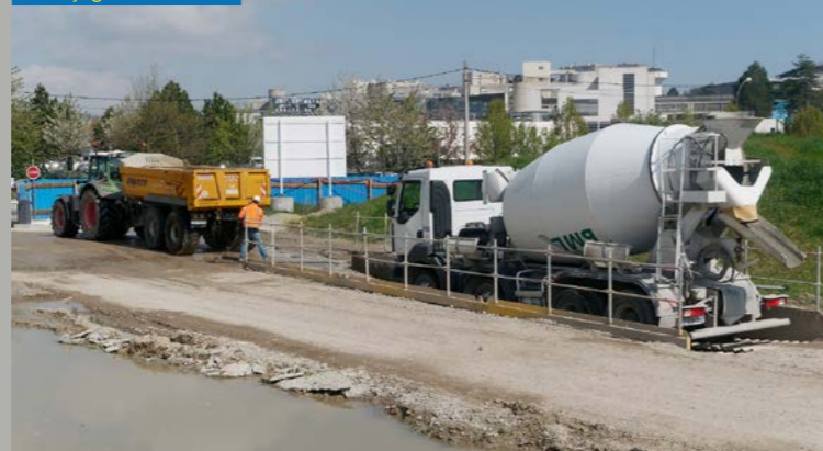
Nettoyage des camions
