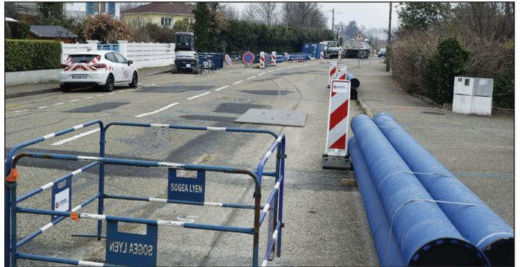
Ces travaux d'une durée de **6 mois** vont permettre le remplacement complet d'une canalisation d'alimentation vieillissante afin de réduire les dysfonctionnements et lutter contre les fuites.
